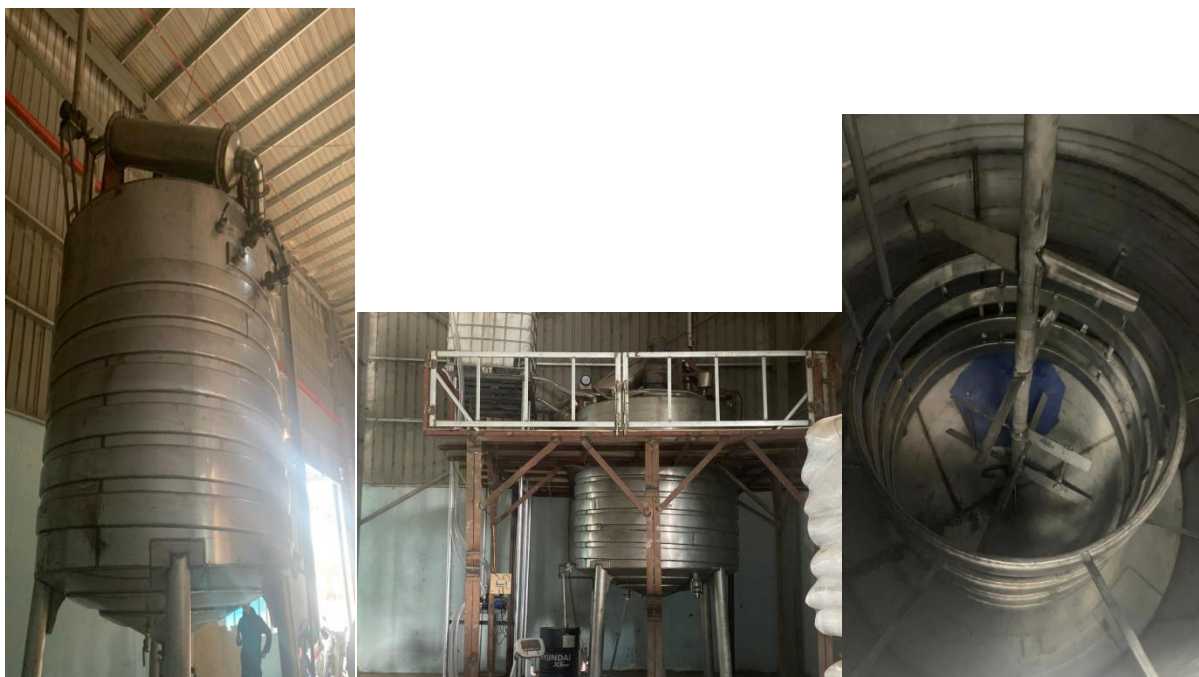
Hình 16. Hệ thống nồi nấu keo tại nhà máy
